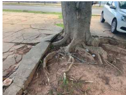
Imagem referência 36: Árvore existente com a raiz danificando a calçada
