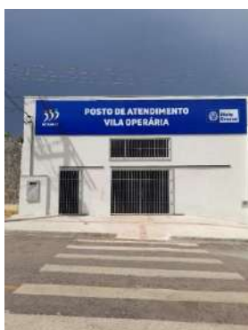
Imagem referêcia 34: Exemplo de fachada em ACM
