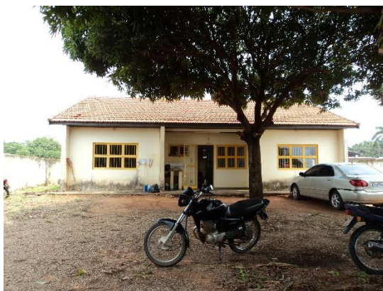
Figura 03: fundos da edificação
