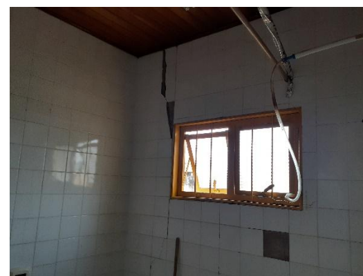
Figura 18: Tubulação de ar condicionado no banheiro
