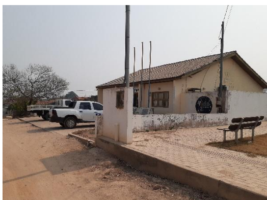
Figura 03: Lateral da edificação
