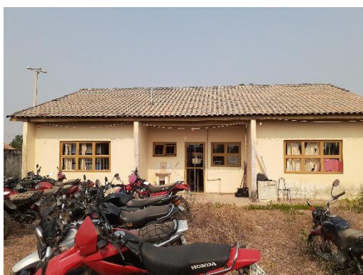
Figura 05: Fundo da edificação
